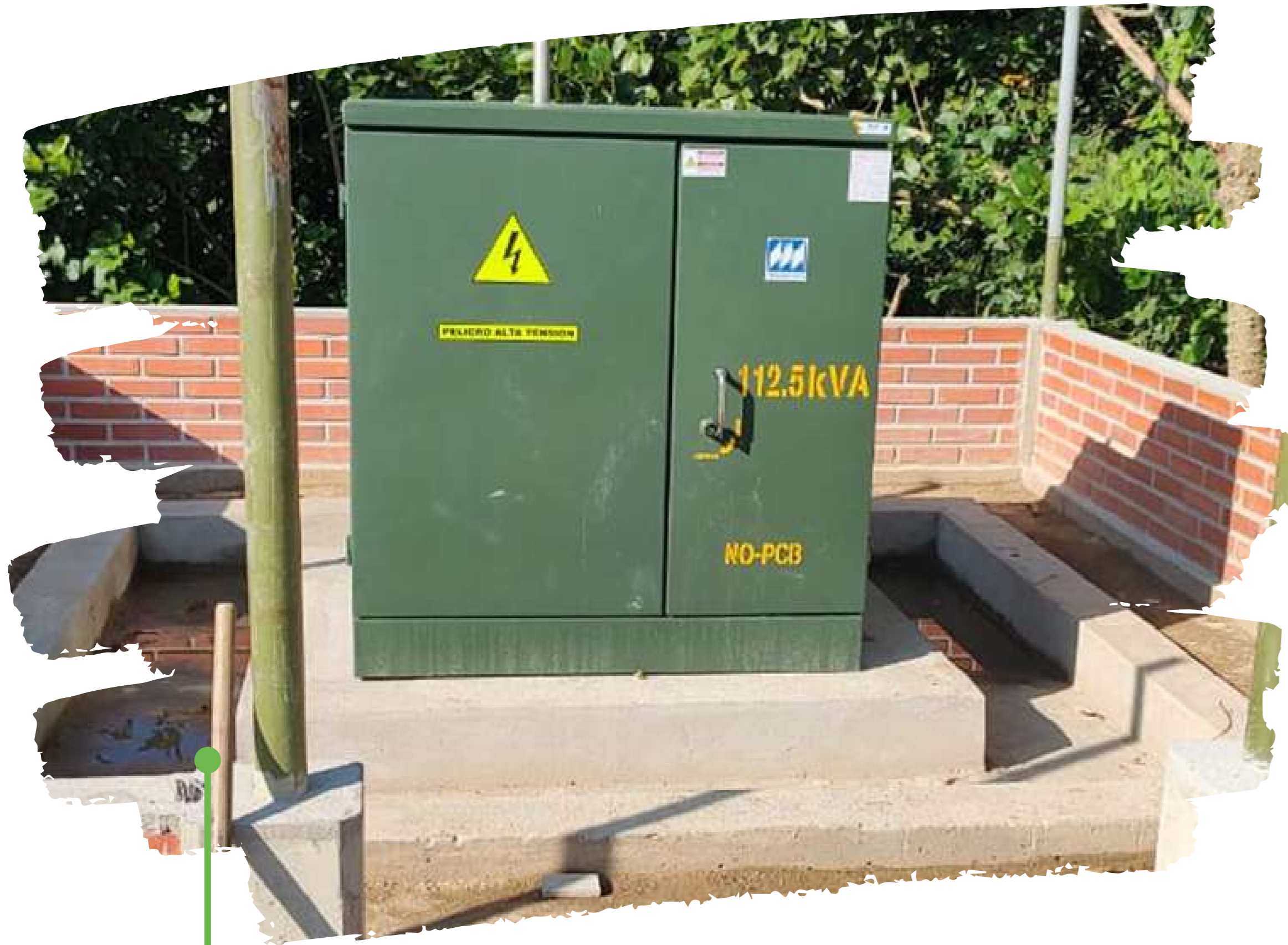
TRANSFORMADOR ELÉCTRICO
